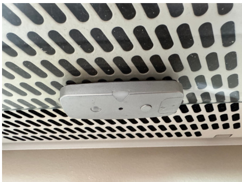
Komfyrvakt v/ kjøkkenventilator.
