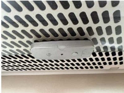
Komfyrvakt v/ kjøkkenventilator.
