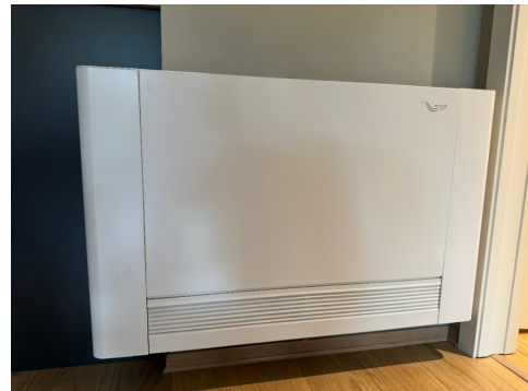
Viftekonvektor i stue/kjøkken.
