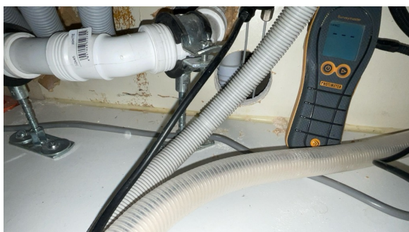
Hulltagning og fuktsøk
