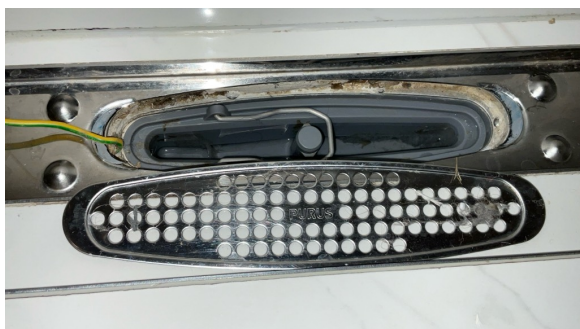
sluk, membran og tettesjikt
