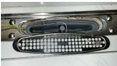
sluk, membran og tettesjikt
