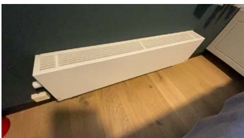
vannbårent varmeanlegg
