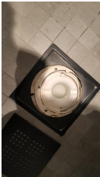
Våtrom - [sluk bad]
