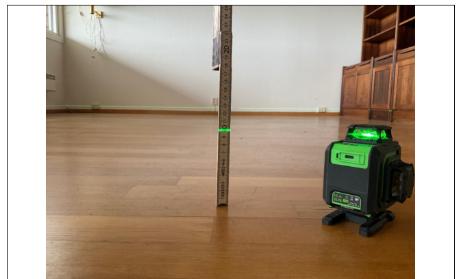
Nivellering av gulv og kontroll av retthet.
