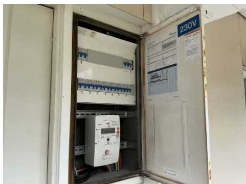
Utvendig sikringsskap.
