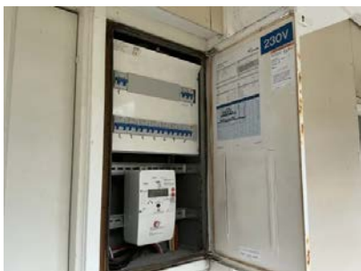
Utvendig sikringsskap.
