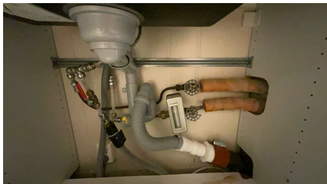
Besiktigelse av røropplegg.
