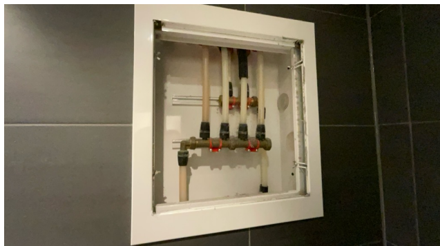
Besiktigelse av røropplegg.
