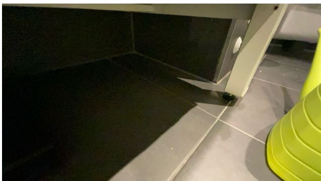
Lekkasjespalte på innebygget sistene bør opparbeides.
