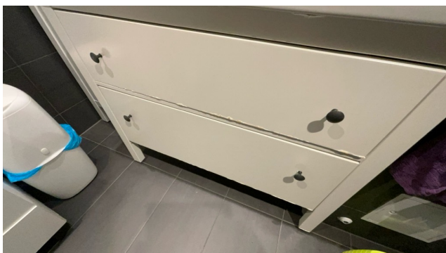
Synlige skader på innredning.
