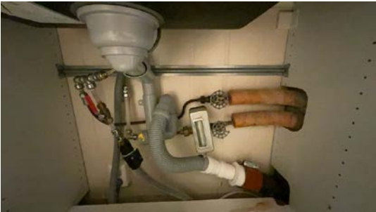
Besiktigelse av røropplegg.
