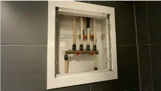
Besiktigelse av røropplegg.
