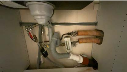
Besiktigelse av røropplegg.
