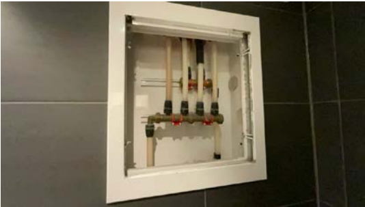
Besiktigelse av røropplegg.
