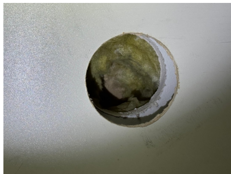
Synlig del av veggkonstruksjon etter hulltaking.
