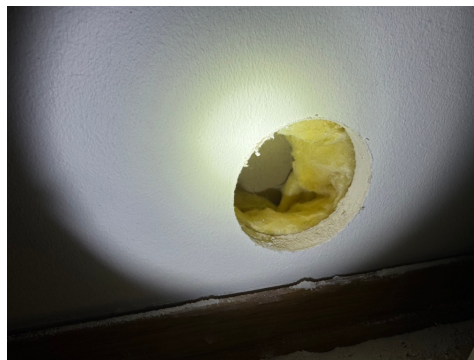
Synlig del av veggkonstruksjon etter hulltaking.
