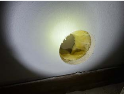
Synlig del av veggkonstruksjon etter hulltaking.
