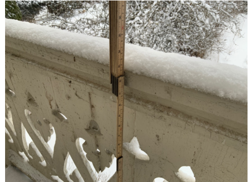
Rekkvershøyde er ca 83 cm.
