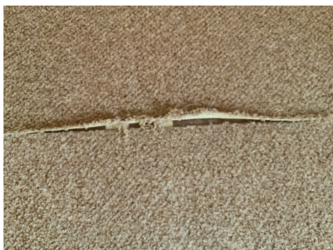
Vegg til vegg teppe løsner
