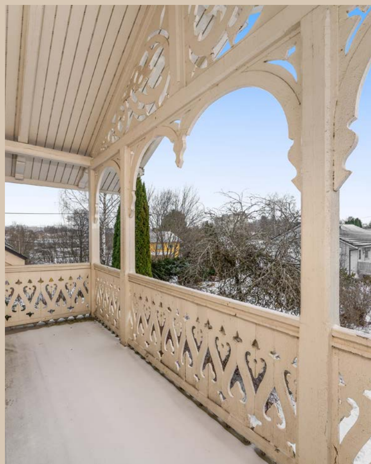
Overbygget balkong i 2.etasje
