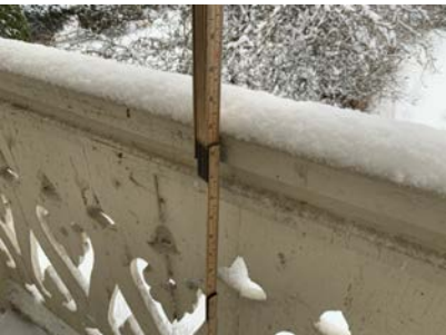
Rekkvershøyde er ca 83 cm.
