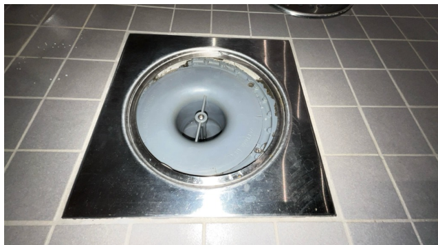
Kontroll av sluk.
