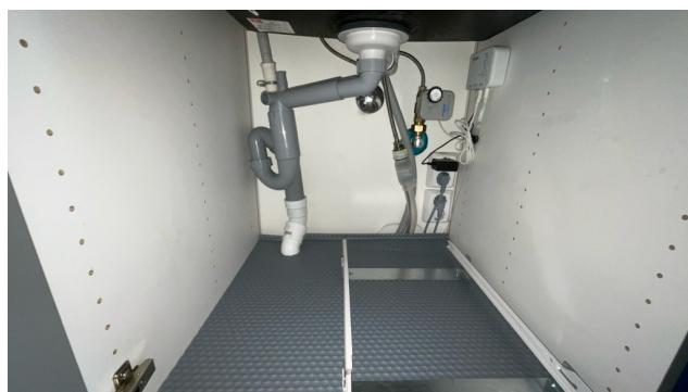
Besiktigelse av røropplegg.
