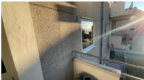
Fasade ved balkong
