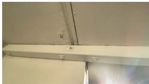
Avflassing i betong på overbygg på balkong
