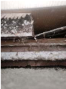
Bilde av luftespalte bak kledning
