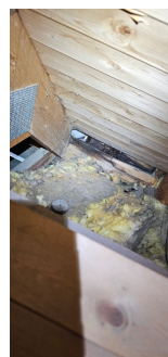
Råte i takkonstruksjonen mellom garasjetak og boligtak.
