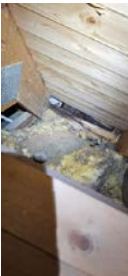
Råte i takkonstruksjonen mellom garasjetak og boligtak.
