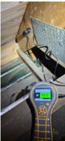
Råte i takkonstruksjonen mellom garasjetak og boligtak.
