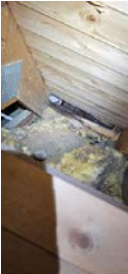
Råte i takkonstruksjonen mellom garasjetak og boligtak.
