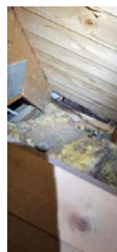
Råte i takkonstruksjonen mellom garasjetak og boligtak.
