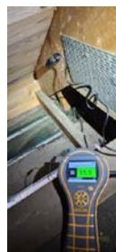
Råte i takkonstruksjonen mellom garasjetak og boligtak.
