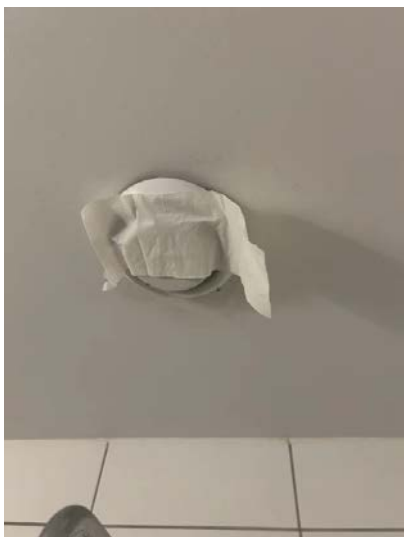
Avtrekk er testet med papir og det registreres sug i kanalen.
