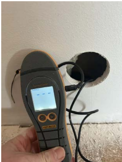
Fuktmålinger i vegg viser ingen tegn til fukt.
