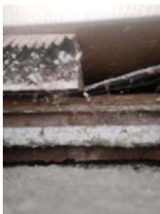
Bilde av luftespalte bak kledning
