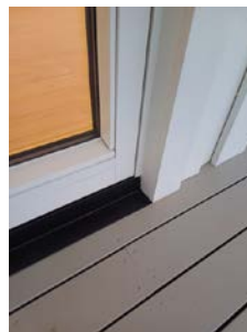
Bilde av beslag på dør og terrasse mot kledning
