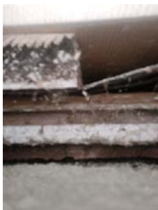
Bilde av luftespalte bak kledning
