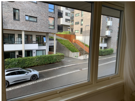
Vinduer med malt treramme
