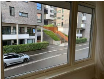
Vinduer med malt treramme
