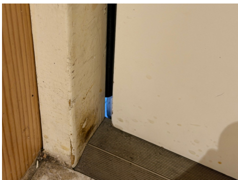
Glip mellom dørblad - pakning.
