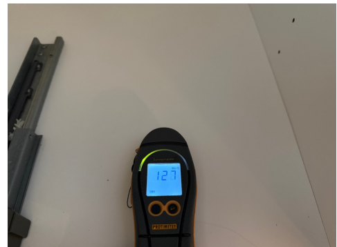
Ingen forhøyede fuktverdier ble registrert i kjøkkenbenken.
