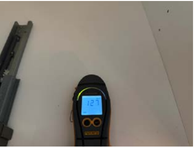
Ingen forhøyede fuktverdier ble registrert i kjøkkenbenken.
