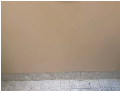
Overgang sokkelflis - baderomsplater i dusjsone.
