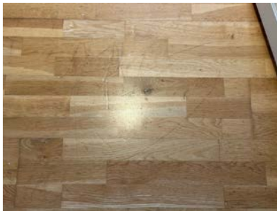
Slitasje/striper i parkettgulv.
