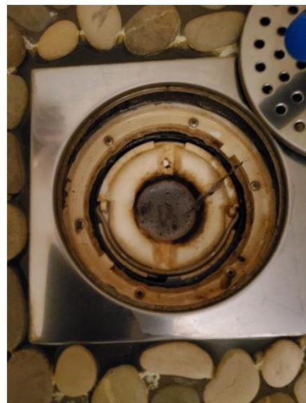
Membran, tettesjikt og overgang til sluk. - [Sluk bad 2.etasje hovedbygning ]
