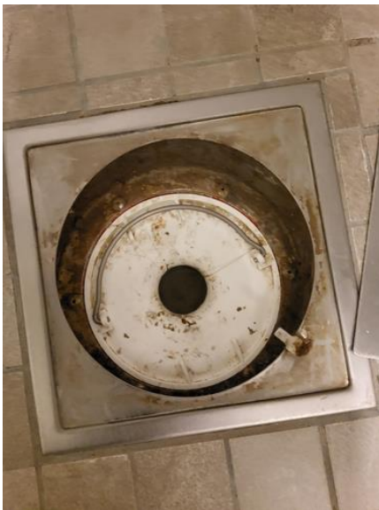
Membran, tettesjikt og overgang til sluk. - [Sluk bad 2.etasje sidebygning ]
