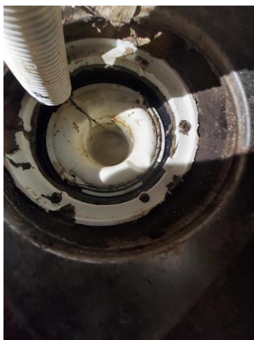
Membran, tettesjikt og overgang til sluk. - [Sluk bad 2.etasje hovedbygning ]
