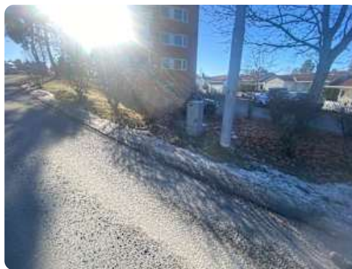
Lysstolper ved internvei
