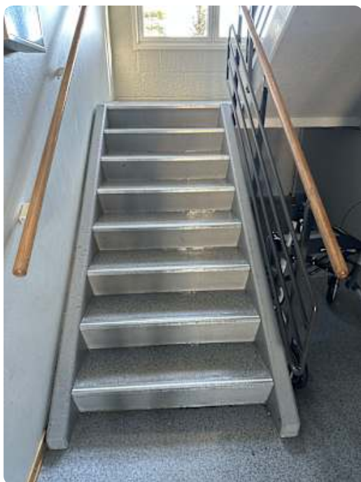
Trappeløp i boligblokk
