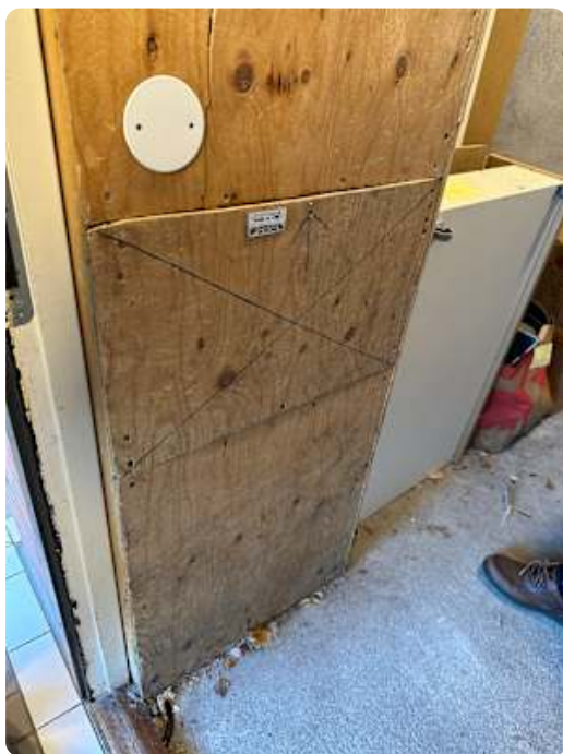
Stoppekraner i fellesarealet
