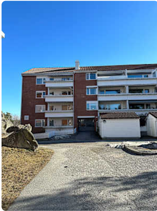
Tak på boligblokk
