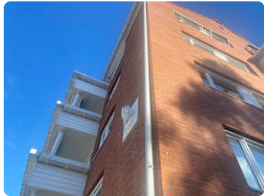
Fasade på boligblokk
