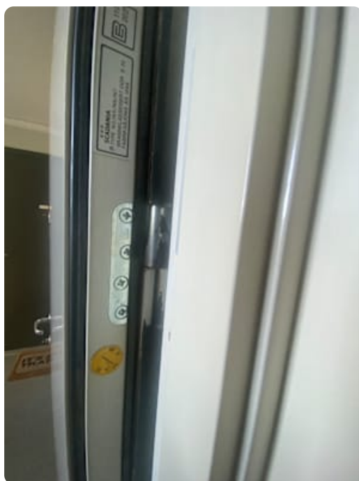
Leilighetsdør til boligblokk
