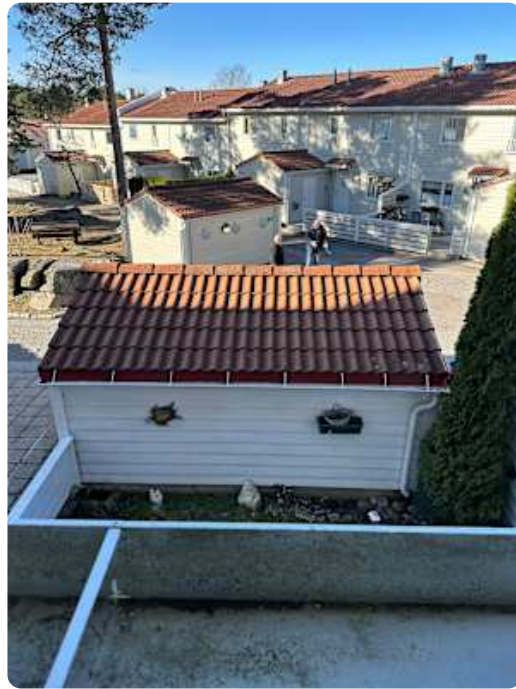
Oversiktsbilde over tak på rekkehus
