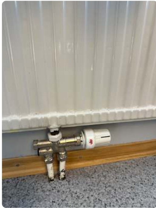
Myke stålrør nedstøpt i radiator
