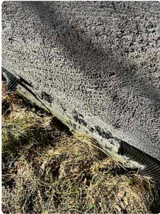
Grunnmur med knoteplast
