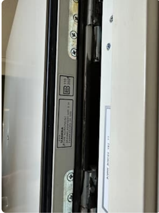
Brannklassifisert inngangsdør i blokk
