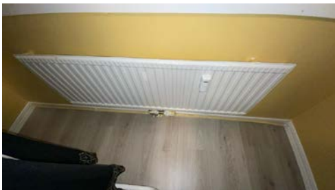
vannbårent varmeanlegg
