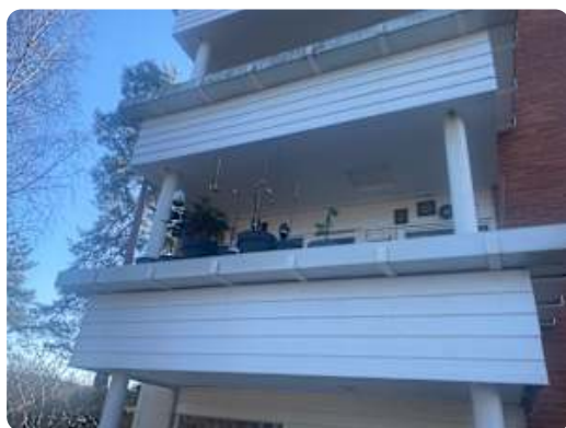
Balkonger i boligblokk
