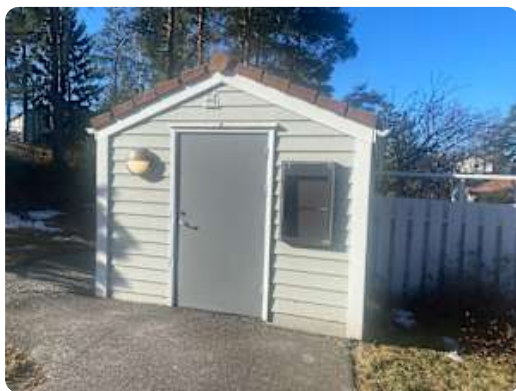
Belysning ved avfallsrom
