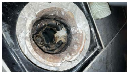
sluk, membran og tettesjikt
