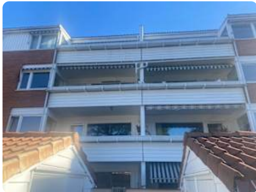
Plateledning på balkonger i boligblokk
