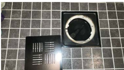
sluk, membran og tettesjikt
