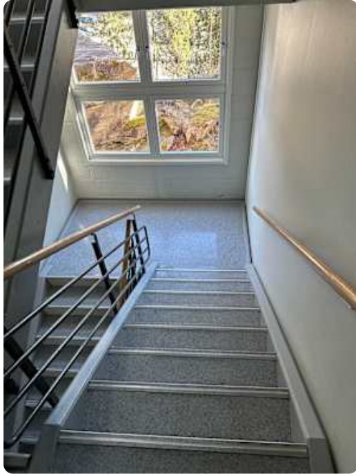
Rekkverk og håndløper på begge sider
