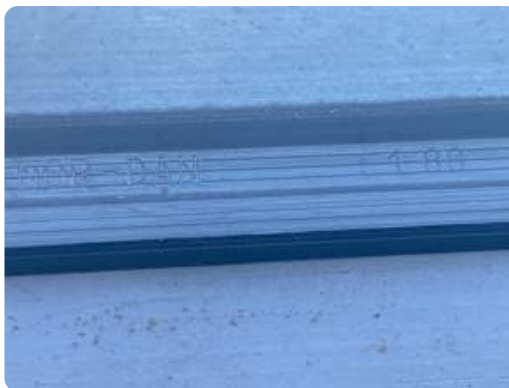
Vindu fra byggeår
