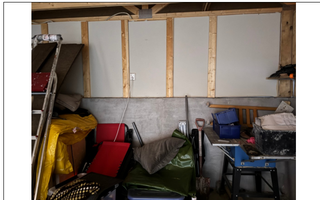
Garasje/velværom: XPS isolasjon på innsiden av vegger i garasje
