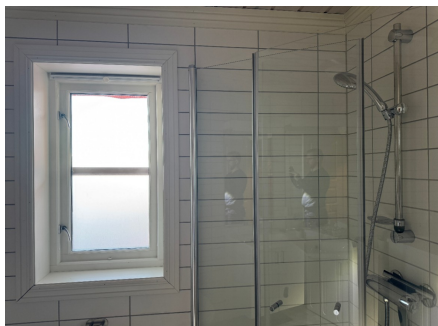
Vindu plassert i våtsone
