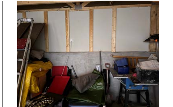
Garasje/velværerom: XPS isolasjon på innsiden av vegger i garasje
