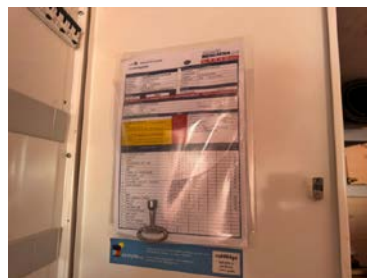
Kursoversikt til sikringsskap
