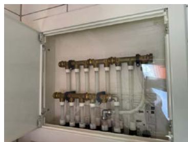
Vannskap montert på teknisk bod
