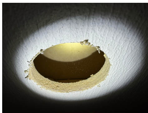
Synlig del av veggkonstruksjon etter hulltaking.
