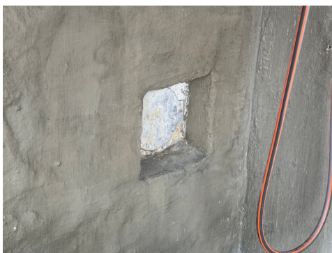
Feieluke v/ inngangsparti.
