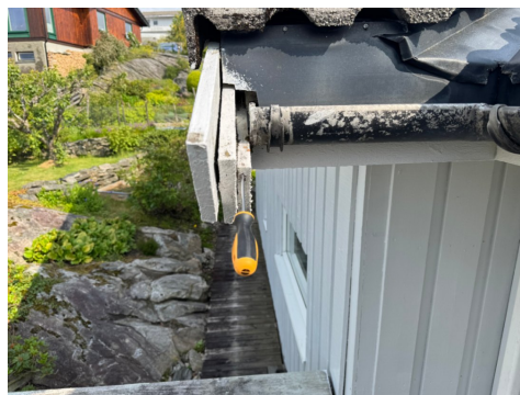
Lokal råte i nedre del av vindskibord.
