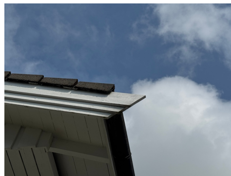
Lokal råte i nedre del av vindskibord.
