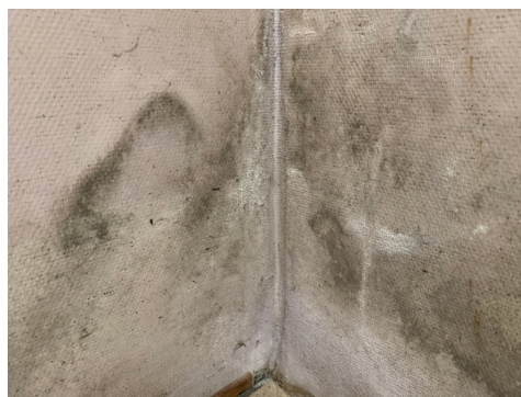
Dreneringen er utilstrekkelig og har idag begrenset effekt.
