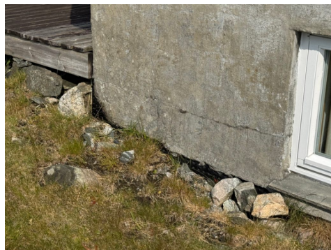
Synlig knotteplast inntil grunnmuren.
