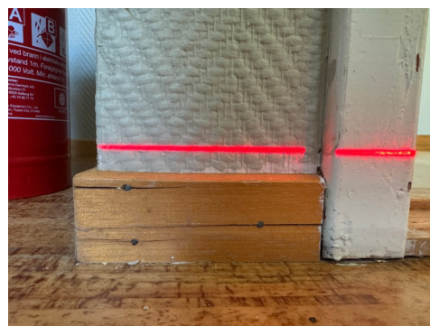
Bilder viser skjevheter i gulv på det ene soverommet i hoved-etg.
