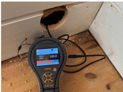
Måling av trefukt/vektprosent.
