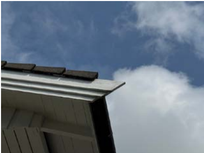
Lokal råte i nedre del av vindskibord.
