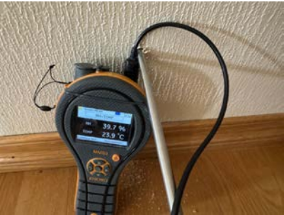
Måling av relativ luftfuktighet.
