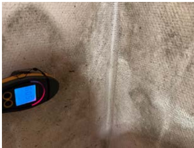
Forhøyede fuktverdier på innside av grunnmur i bod.
