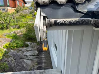
Lokal råte i nedre del av vindskibord.
