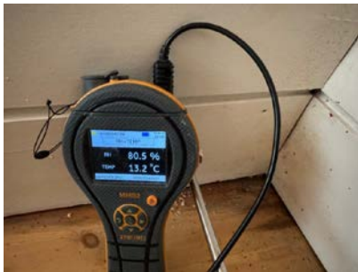
Måling av relativ luftfuktighet.
