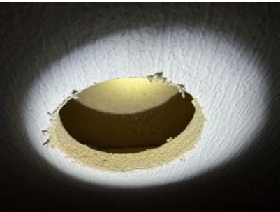
Synlig del av veggkonstruksjon etter hulltaking.
