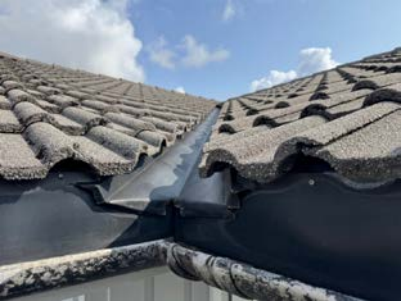
Taktekking sett fra stige.
