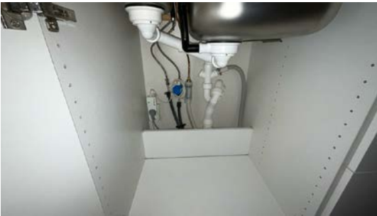
Besiktigelse av røropplegg.
