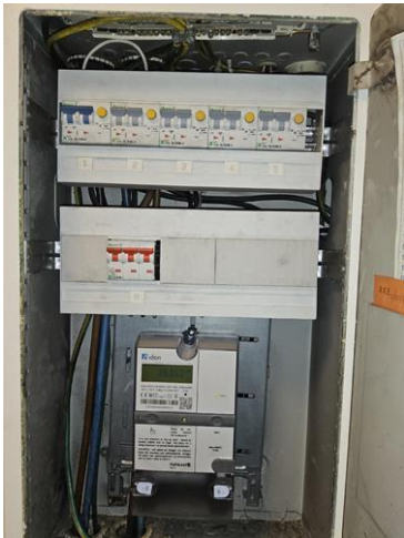
Beskrivelse - [Sikringsskap. ]
