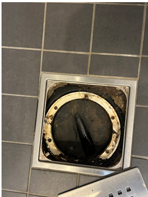
Sluk på bad i 1.etasje
