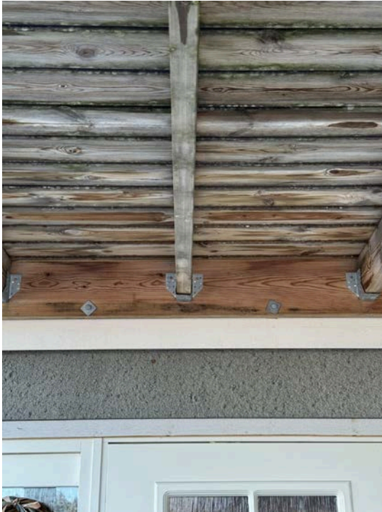
Balkonggulv sett fra undersiden.
