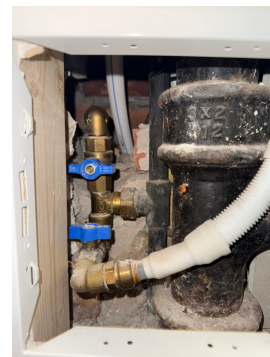
Stoppekraner bak luke i mellomgang.
