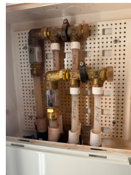
Stoppekraner bak luke i mellomgang.
