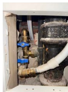
Stoppekraner bak luke i mellomgang.
