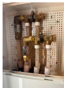
Stoppekraner bak luke i mellomgang.
