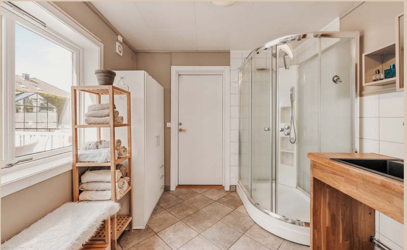
Badet i 1.etasje har fliser på gulv og er innredet med servant, toalett og dusjkabinett.
