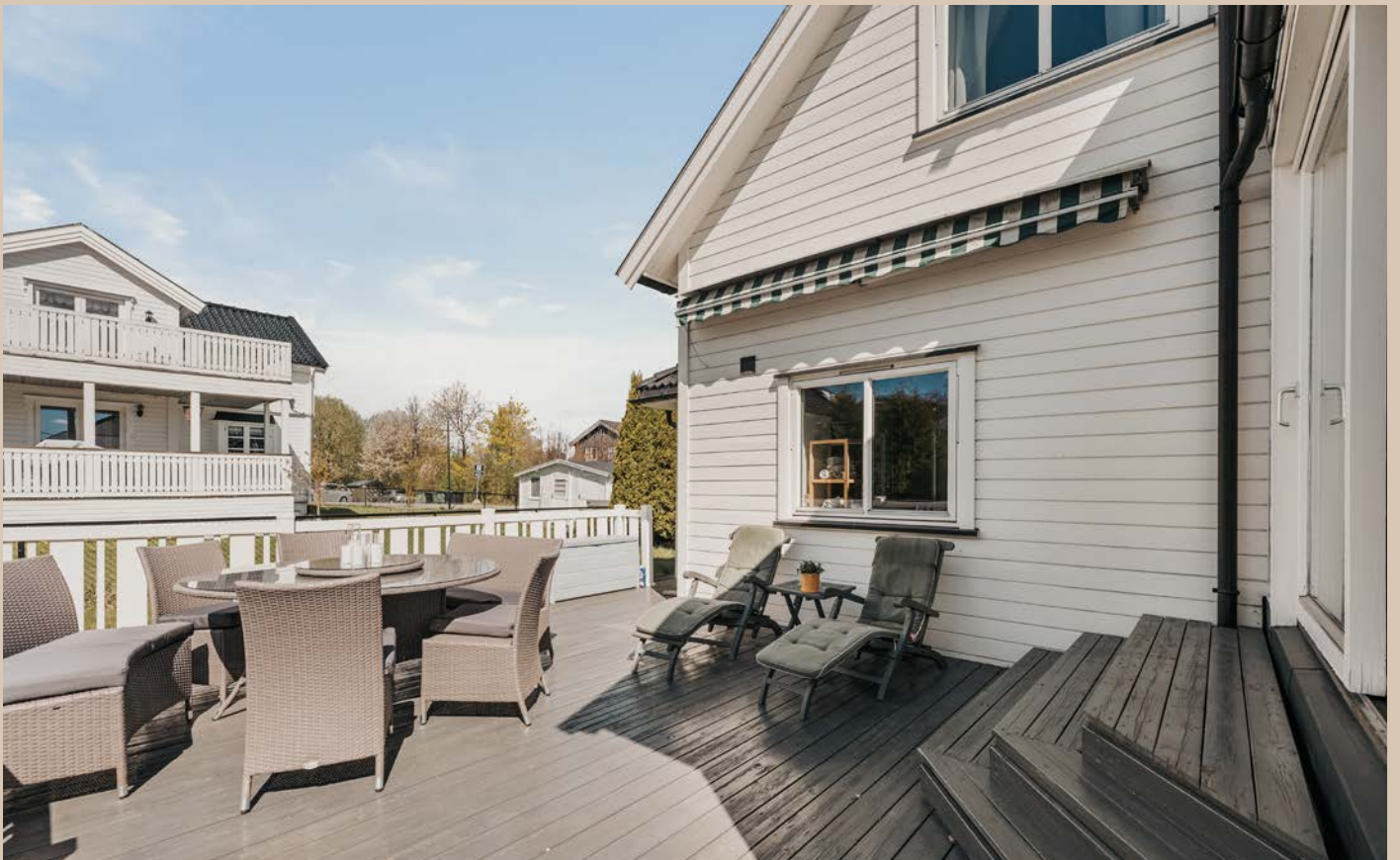
Det er montert markise.
