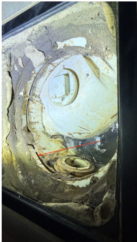
Eksempelbilde av glippe mellom klemring og sluk.
